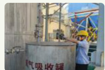
9. 维修人员进场检修
