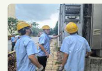
7. 治理设施检查维修
