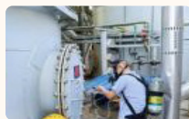
5. 检测受限空间内氧含量及 CO 气体浓度
