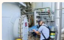
5. 抢修组切断加油站供电
